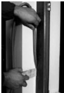
La figura raffigura l'operazione di inserimento del cordolo (operazione 1).
