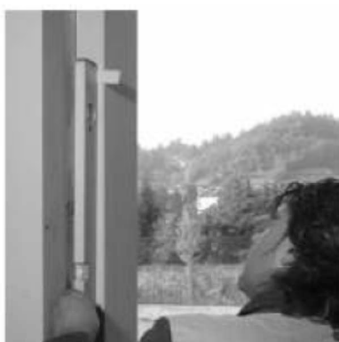
L'immagine a lato raffigura l'operazione di controllo del piombo del telaio, operazione preliminare rispetto al fissaggio e molto importante.
