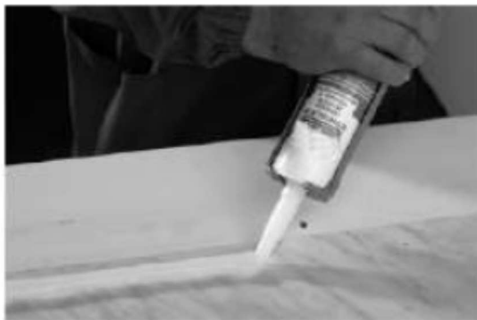
Figura a sinistra: Applicazione del cordolo di tenuta sul davanzale in corrispondenza della mezzaria del telaio della finestra.
