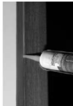
La figura raffigura l'operazione di sigillatura del giunto di dilatazione (operazione 3).
